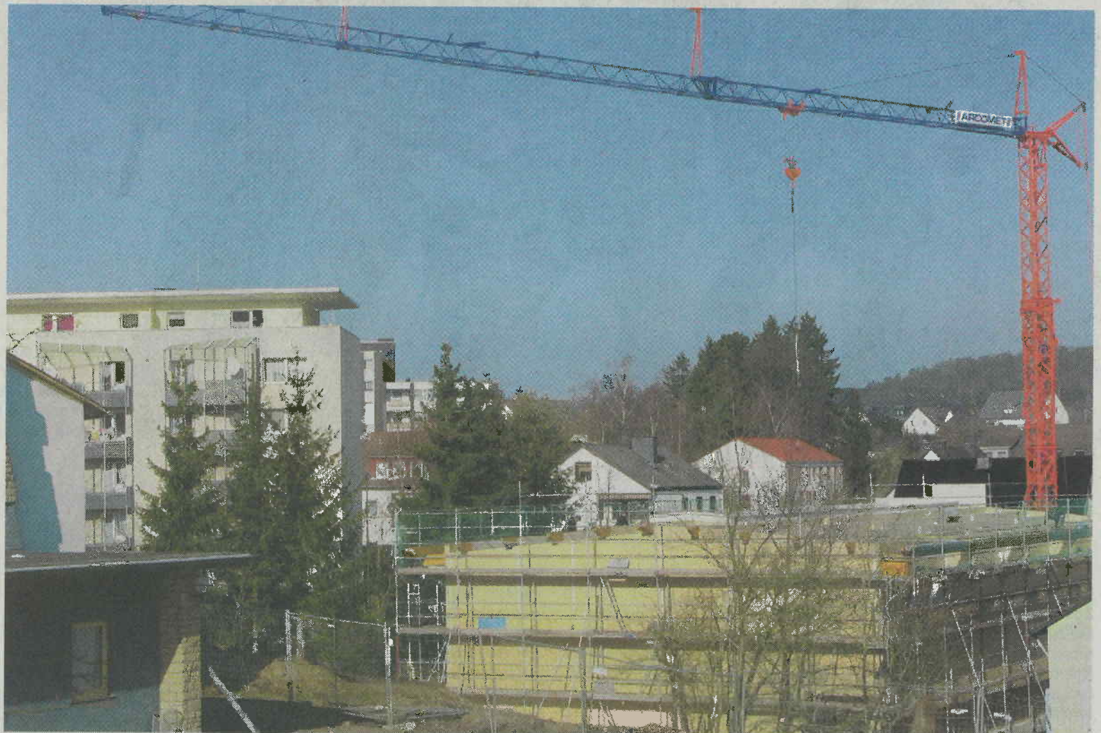
Weit vorangeschritten ist der Neubau der zweiten Turnhalle auf dem Gelände der Grundschule Daun. Derzeit laufen die Dacheindeckungsarbeiten.
